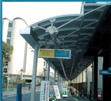
阪神西宮歩道屋根
