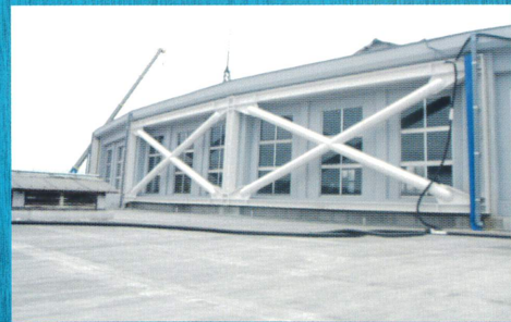
梅小路車庫耐震補強
